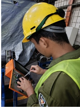
Foto sedang wiring junction box di PT. Elang Perdana
