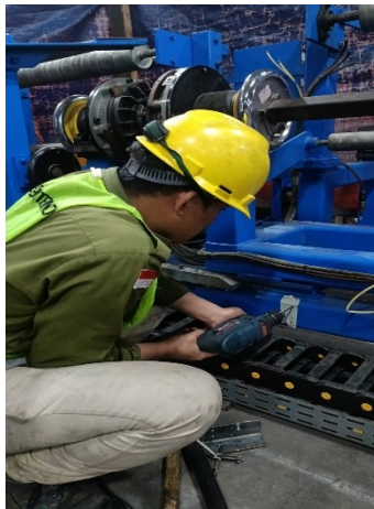
Foto sedang membore untuk pemasangan sensor di PT. Elang Perdana
