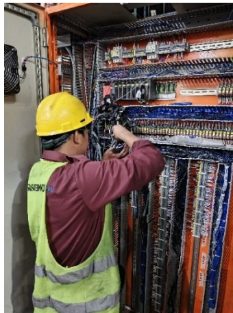
Gambar 4. 20 Proses wiring pada panel control PT. Elang Perdana
