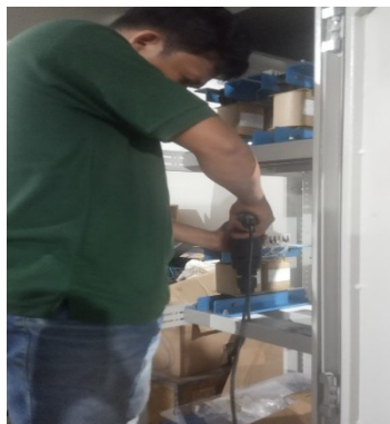
Gambar 4. 19 Pemasangan komponen pada proyek PT. Bukit Asam
