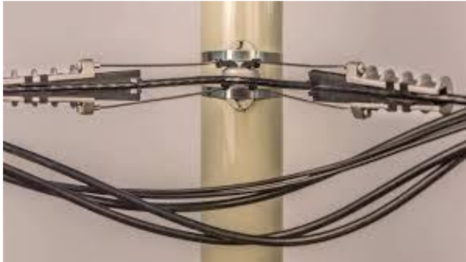
Gambar 2. 3 Pemasangan Accesories Suspencion Clamp ( Sumber: https://i.ytimg.com )
