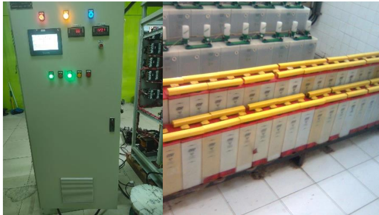
Gambar 2.2 Sistem Catu Daya 110V Sumber: (blog.kliknclean.com)
