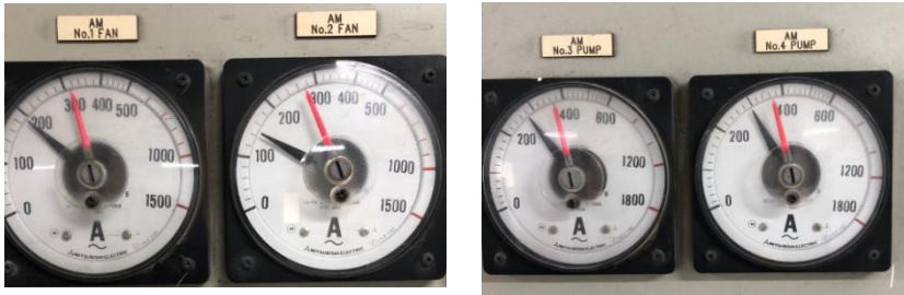
Gambar 4. 8 Amperemeter Motor dan CT
