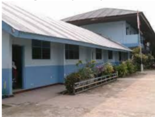
Gambar 2. 1 Gedung SMP Dakwah Pekanbaru
