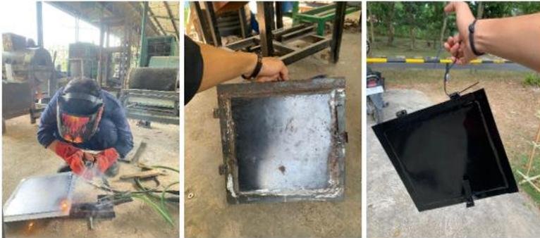
Gambar 4. 10 Proses Pengerjaan pada Tungku Pembakaran.
