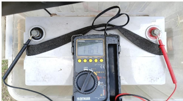
Gambar 4. 6 Proses pengukuran tegangan baterai
