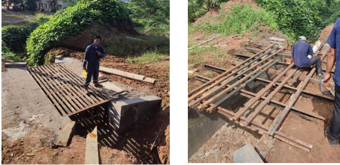
Gambar 4. 10 Proyek Pembangunan Jembatan di Afdelling II
