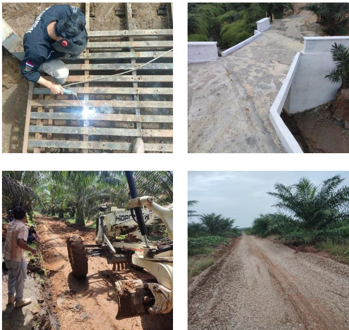
Gambar 2. 6 Pembangunan Infrastruktur di Area Perkebunan
