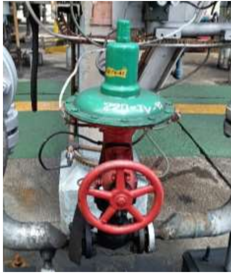
Gambar 4.1 Pemasangan Control Valve
