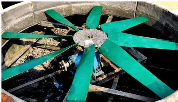
Gambar 4. 1 Gambar bilah kondensor
