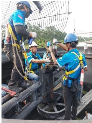
Gambar 4. 10 pelepasan blade lama
