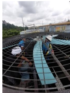
Gambar 4. 11 pemasangan blade baru
