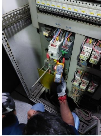
Gambar 4. 12 pengecekan amper kondesor setelah di ganti blade
