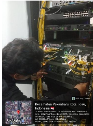
Gambar 4. 5 Pemasangan MDA
