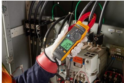
Gambar 3. 3 Pengecekan Daya yang Masuk
