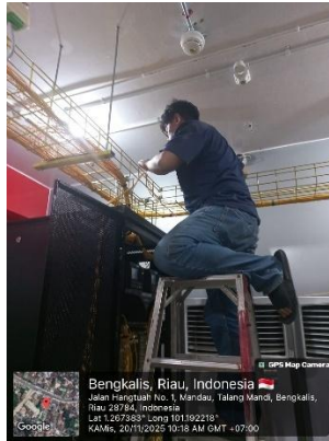
Gambar 4. 4 Instalasi Kabel Patch Core baru
