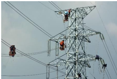
Gambar 2. 8 Sistem Transmisi PLN
