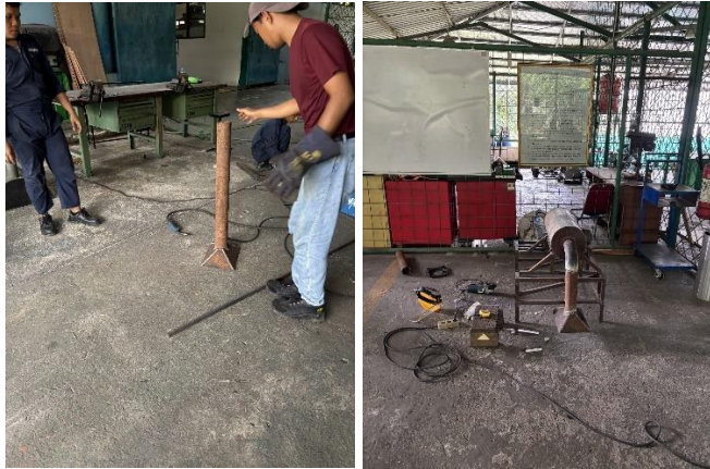
Gambar 4.4 Proses Pengerjaan Pipa Pemanas
